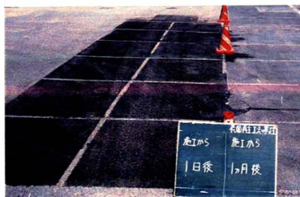
写真-1 試験施工後の状況
